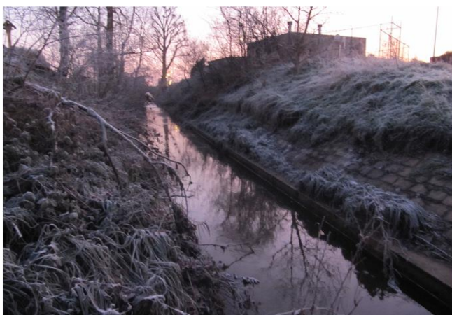
Foto gegen Fließrichtung
