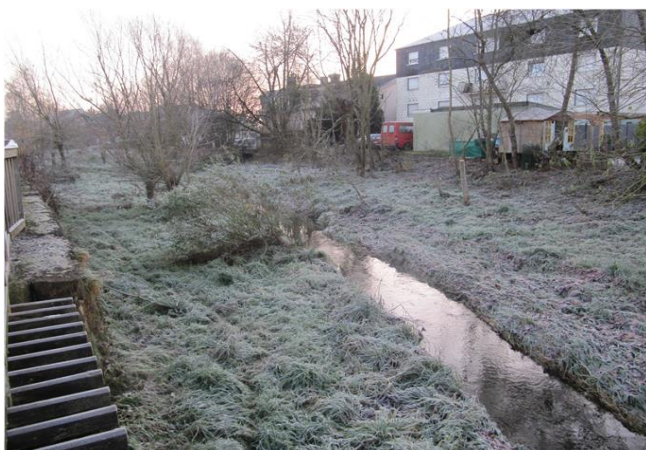
Foto gegen Fließrichtung
