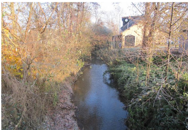
Foto gegen Fließrichtung
