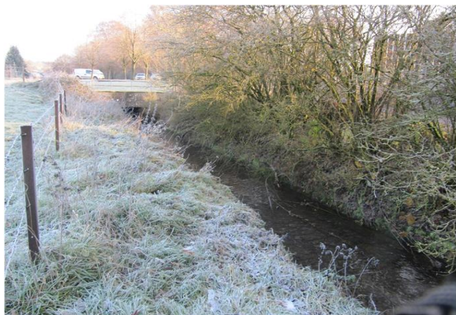
Foto gegen Fließrichtung
