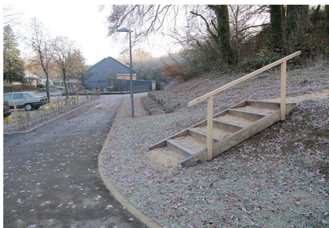
Foto gegen Fließrichtung
