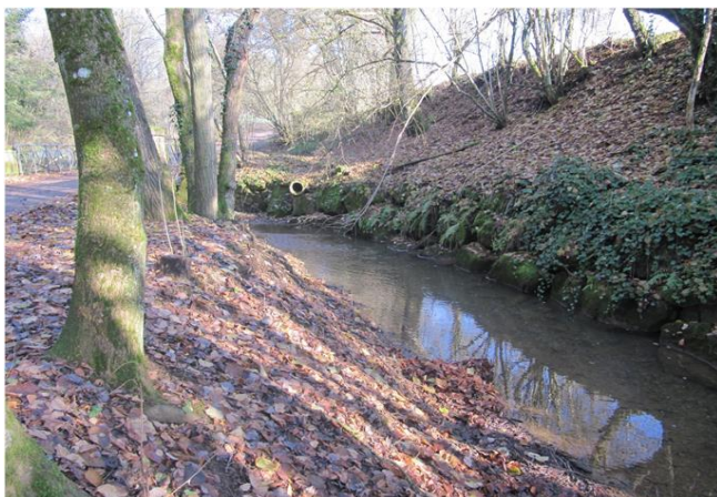
Foto gegen Fließrichtung
