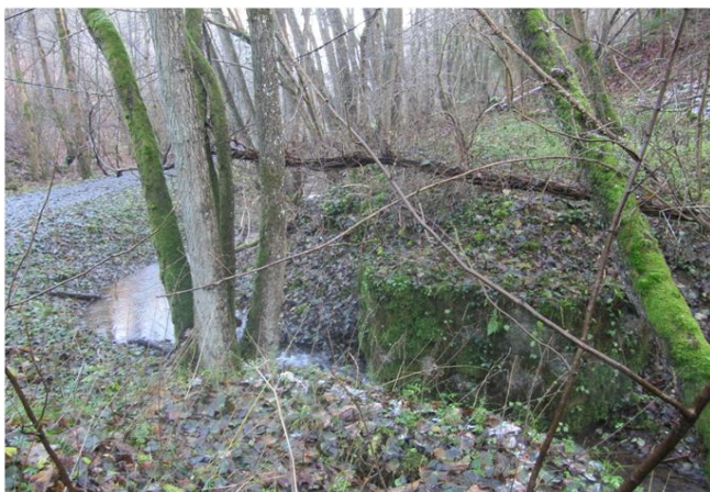
Foto gegen Fließrichtung
