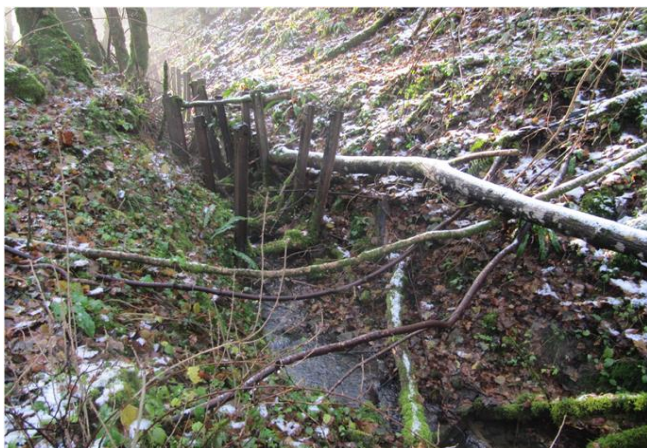
Foto gegen Fließrichtung
