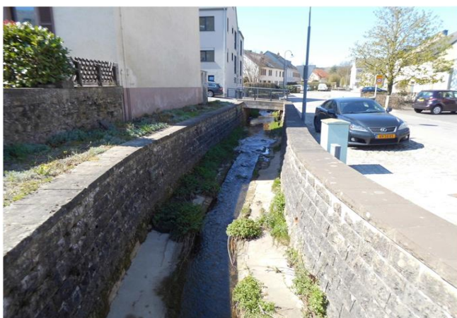
Foto gegen Fließrichtung
