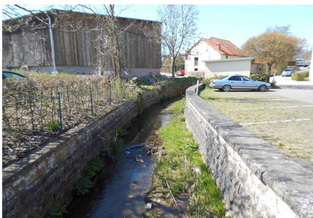
Foto gegen Fließrichtung
