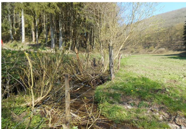
Foto gegen Fließrichtung
