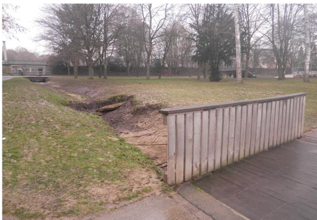
Foto gegen Fließrichtung
