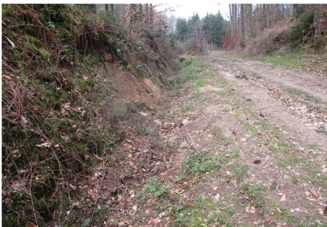
Foto gegen Fließrichtung
