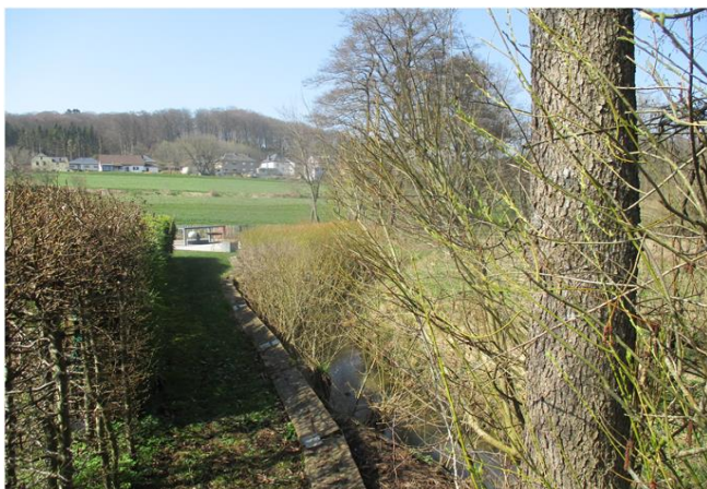
Foto gegen Fließrichtung
