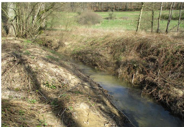
Foto gegen Fließrichtung
