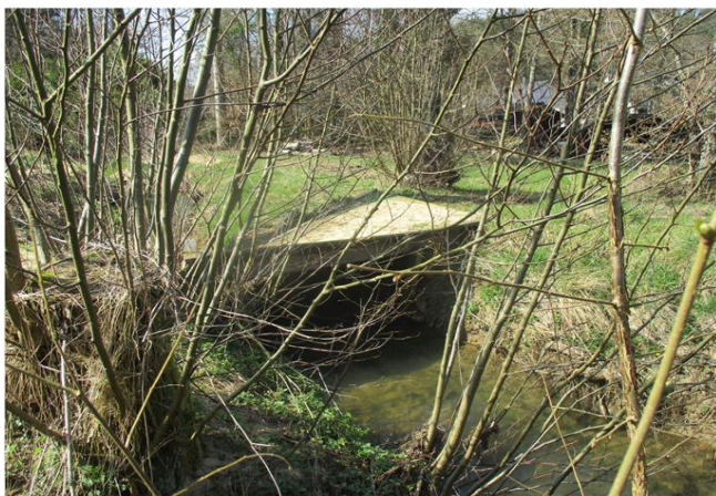
Foto gegen Fließrichtung
