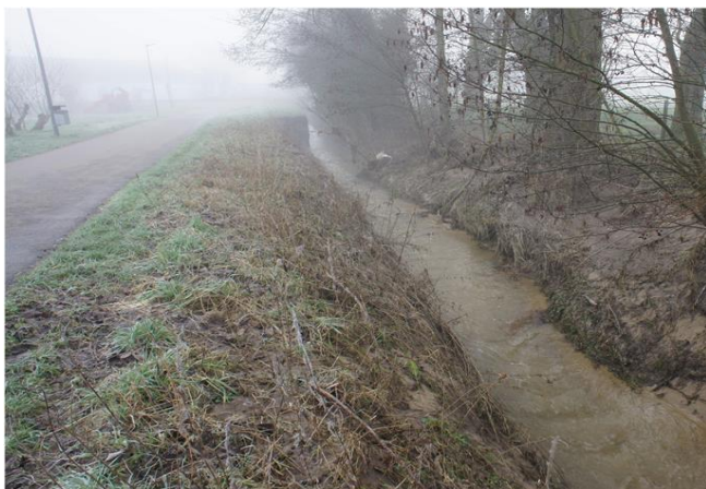
Foto gegen Fließrichtung
