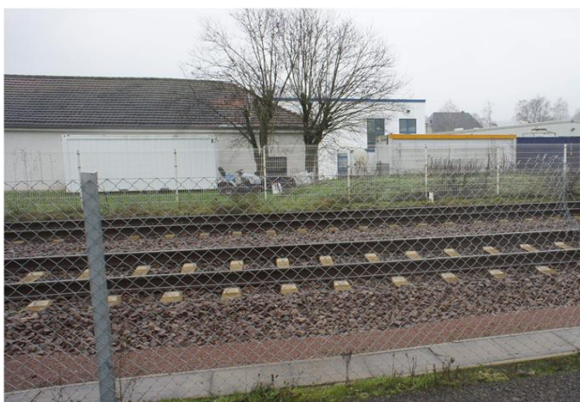
Foto gegen Fließrichtung
