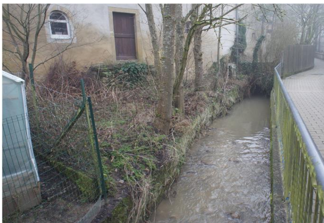
Foto gegen Fließrichtung
