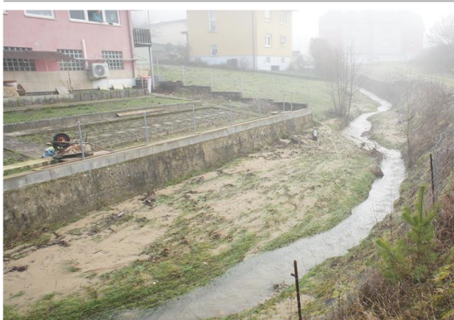
Foto gegen Fließrichtung
