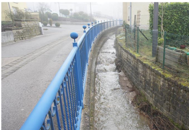
Foto gegen Fließrichtung
