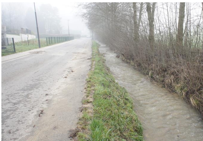
Foto gegen Fließrichtung
