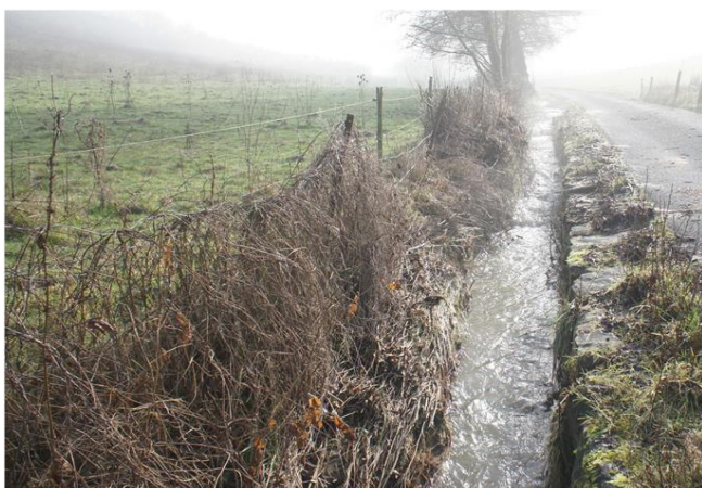
Foto gegen Fließrichtung
