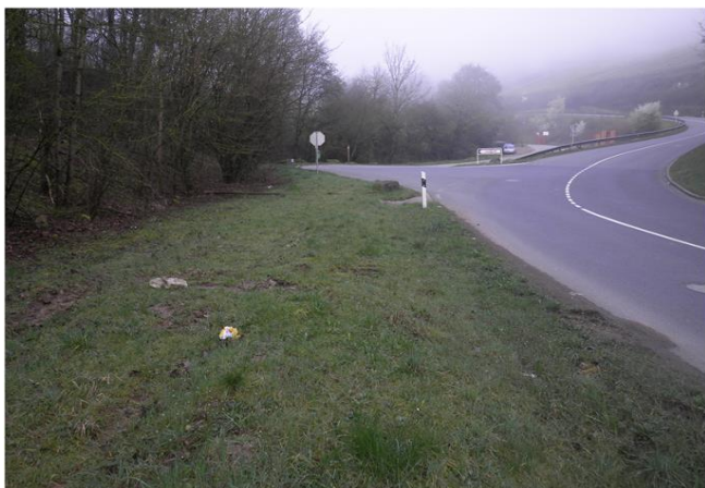
Foto gegen Fließrichtung
