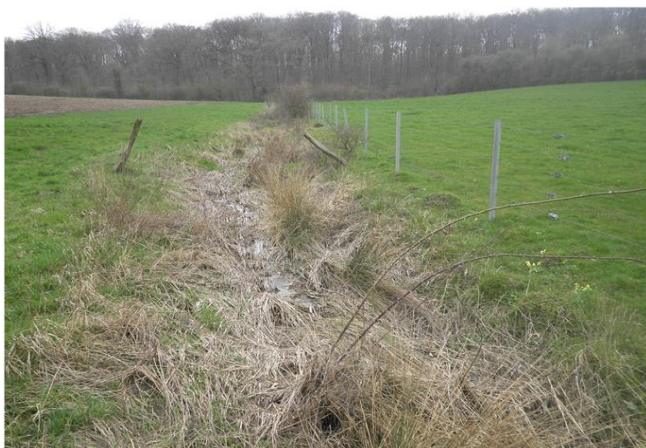
Foto gegen Fließrichtung
