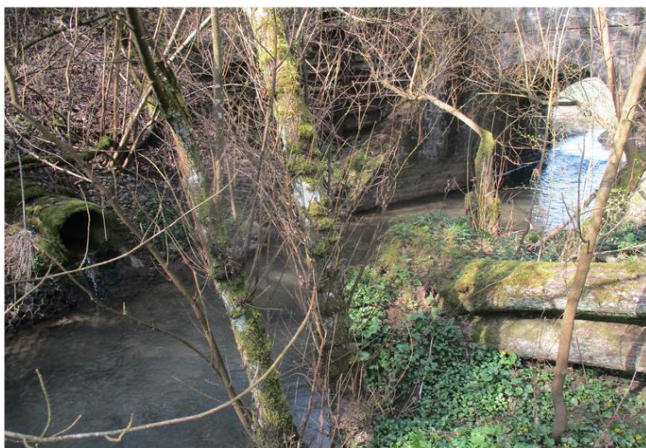
Foto gegen Fließrichtung
