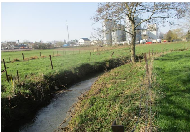
Foto gegen Fließrichtung
