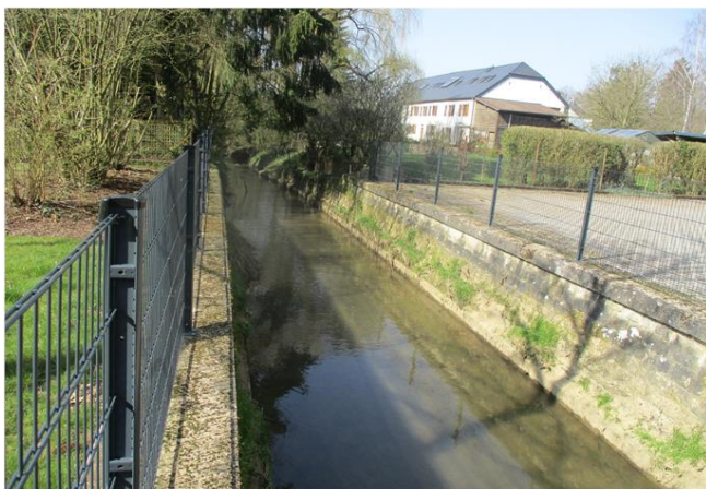
Foto gegen Fließrichtung
