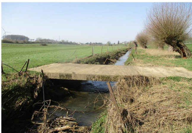
Foto gegen Fließrichtung
