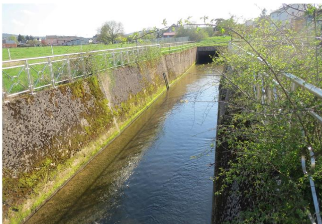
Foto gegen Fließrichtung
