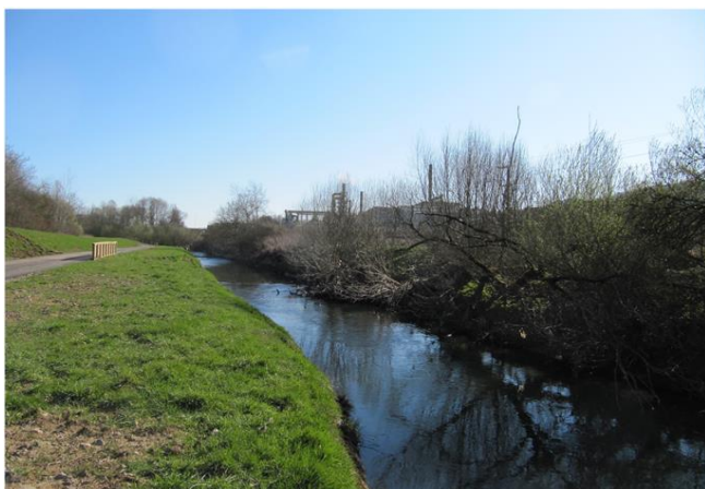
Foto gegen Fließrichtung
