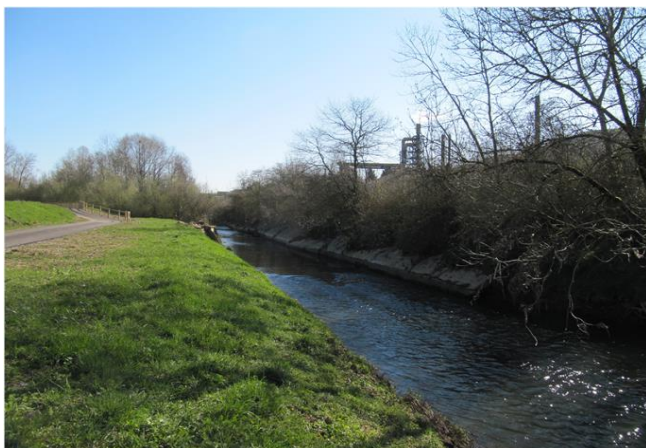
Foto gegen Fließrichtung
