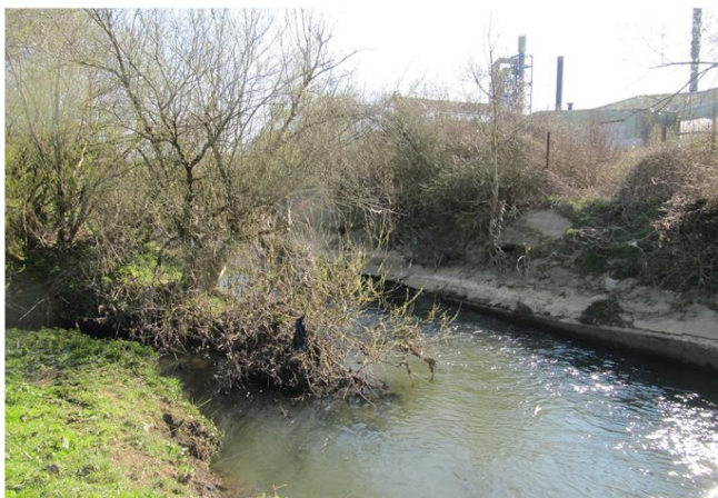
Foto gegen Fließrichtung
