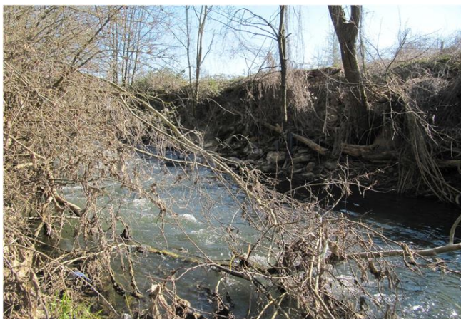
Foto gegen Fließrichtung
