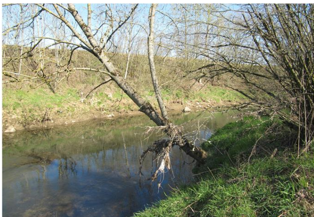
Foto gegen Fließrichtung
