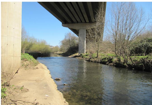
Foto gegen Fließrichtung
