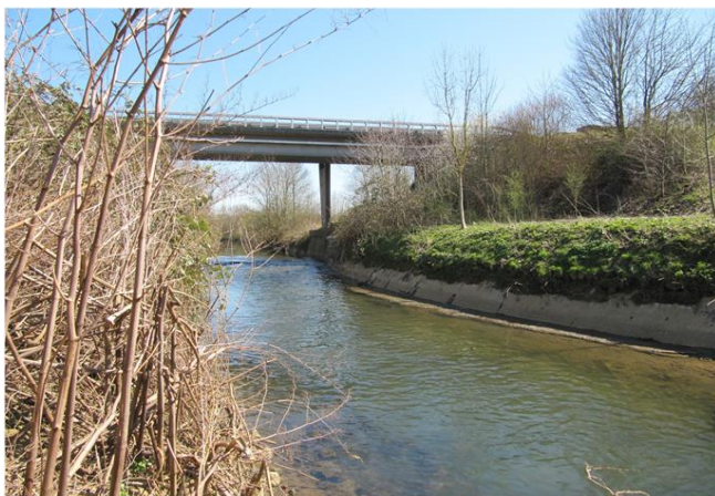
Foto gegen Fließrichtung
