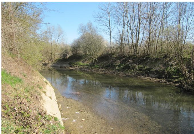
Foto gegen Fließrichtung
