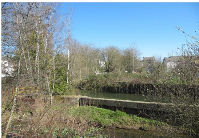
Foto gegen Fließrichtung
