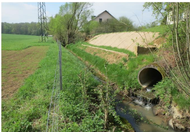
Foto gegen Fließrichtung
