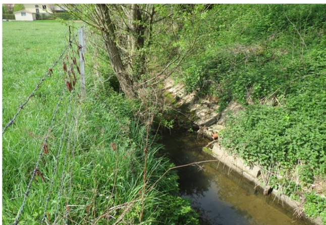
Foto gegen Fließrichtung
