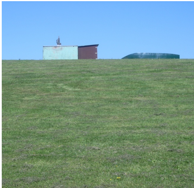
Image 13 : station de pompage pour la cabane d'élevage à truites
