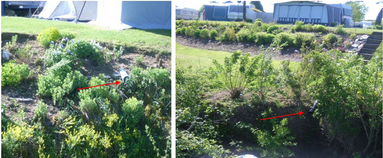
Image 15: tuyaux de drainage du camping déversant dans le Kailsbach
